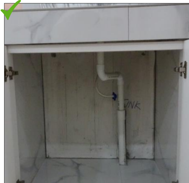
Contoh sistem paip yang diterima (non-corrugated pipe)
