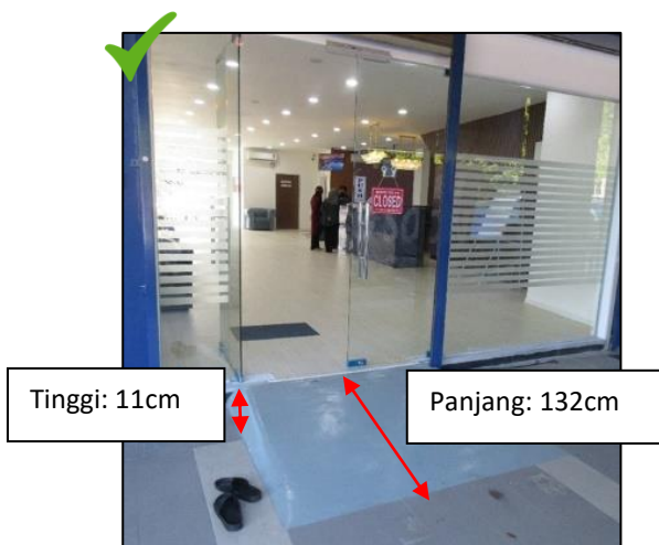
Ramp di hadapan pintu masuk klinik 1:12
